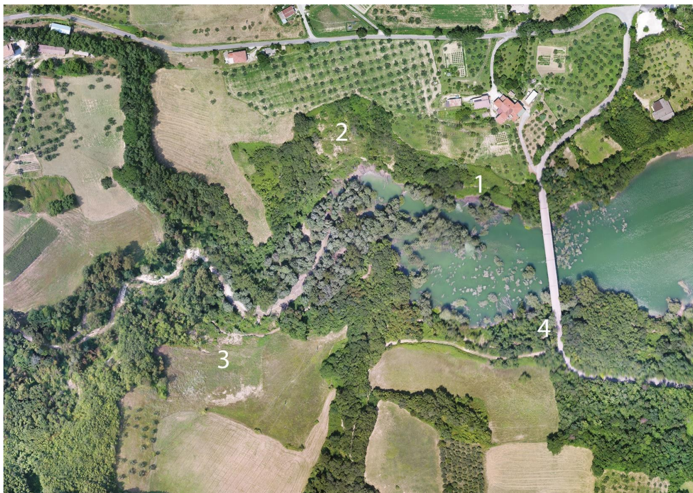
Figura 2. Aree d'intervento del progetto “intervento di consolidamento e riduzione del rischio dissesto sponde della diga di Penne” individuate con il volo del drone nel mese di ottobre del 2018, con indicate numericamente le aree d'intervento.
